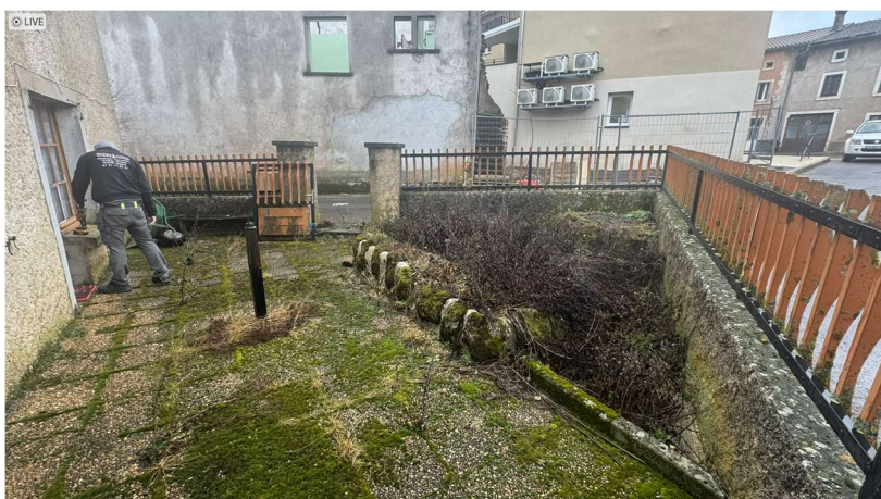
Courette aspect Sud-Ouest
