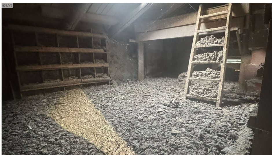
Partie des combles envahie par les déjections
