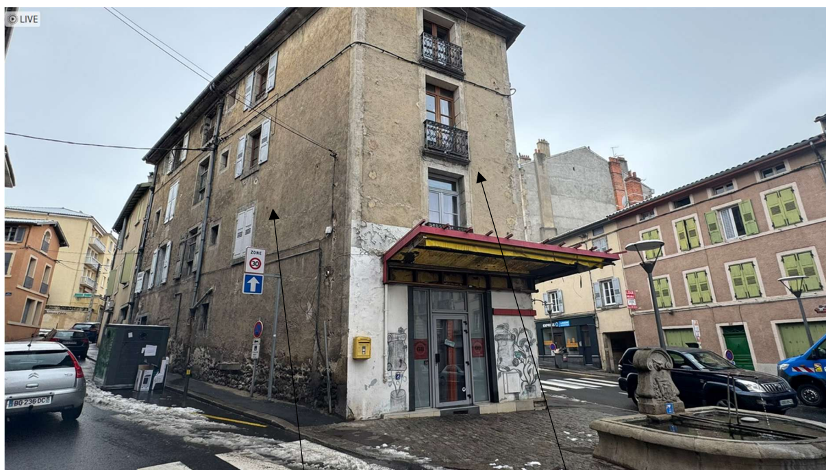
Façade côté rue Emile Reynaud (Exposition Est) / Aspect Nord
