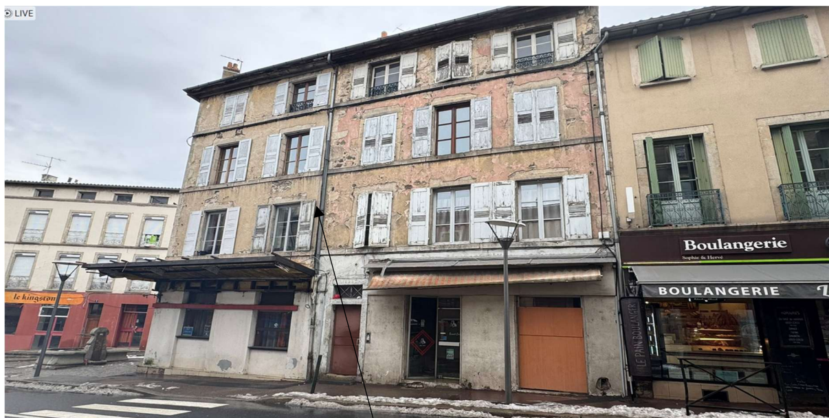
Façade exposée Ouest, côté avenue Maréchal Foch
