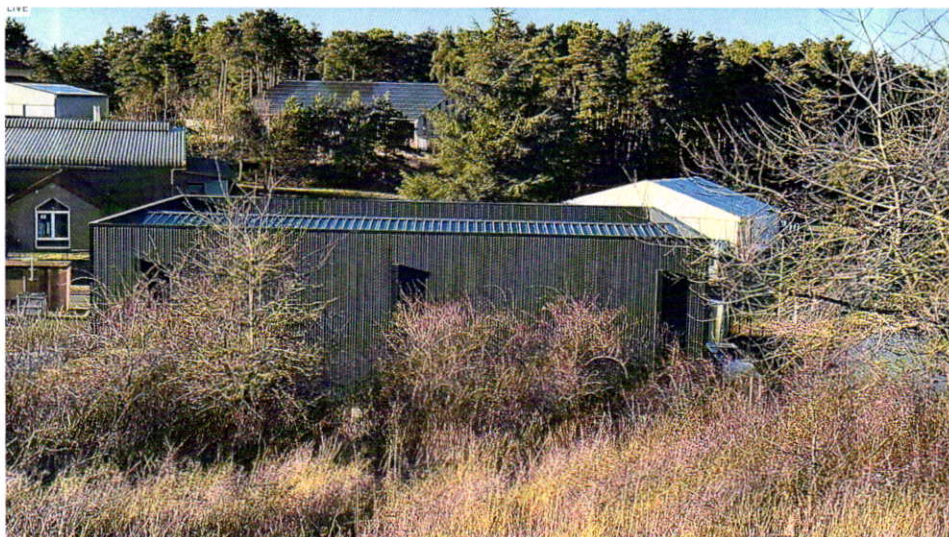
Photo de la toiture prise au sein du tènement voisin en surplomb du tènement objet de notre expertise
