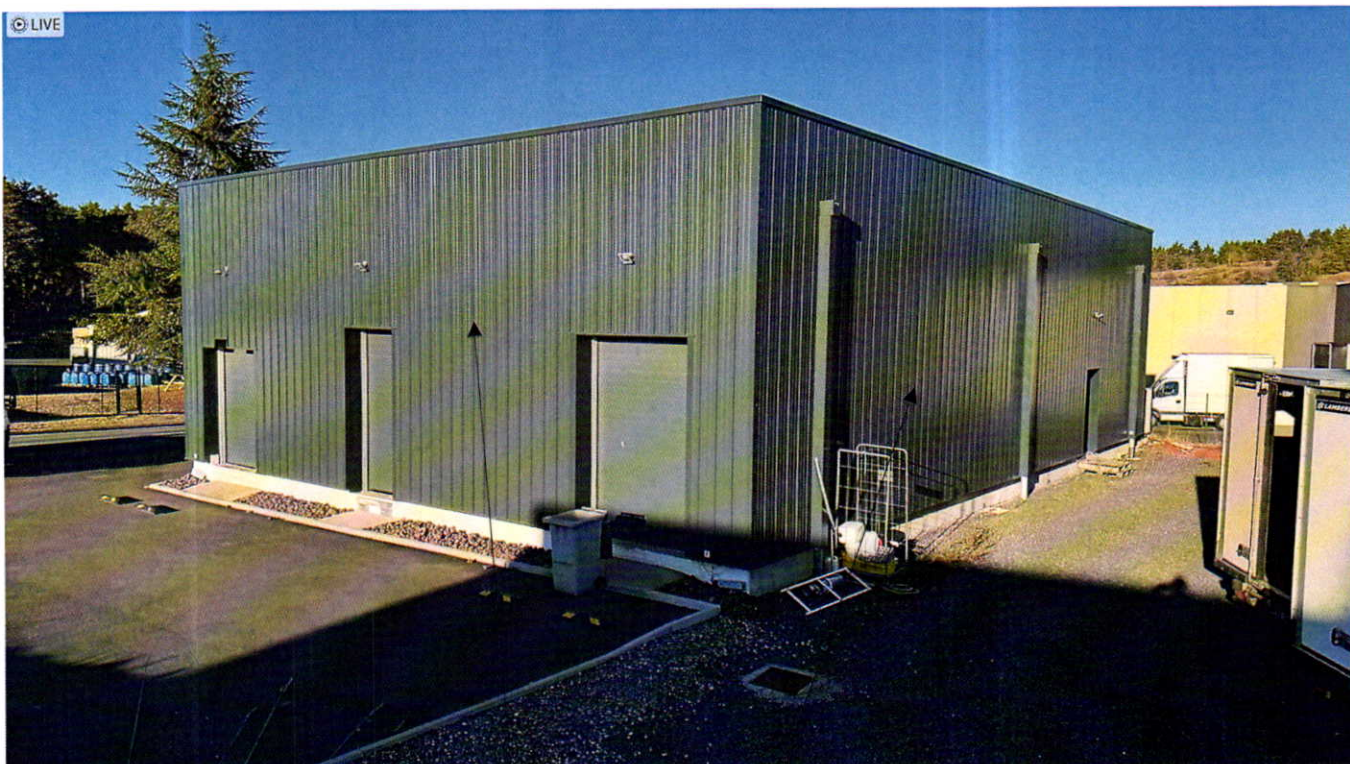
Aspect Sud-Ouest (Atelier) / Aspect Sud-Est (Atelier)
