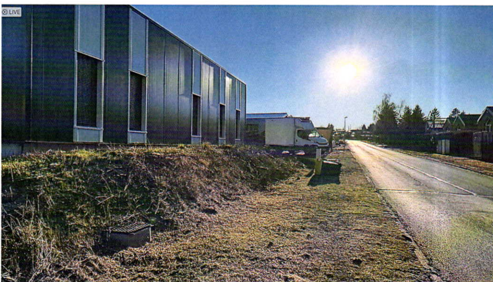
Terrain se développant au Nord-Ouest du bâti
