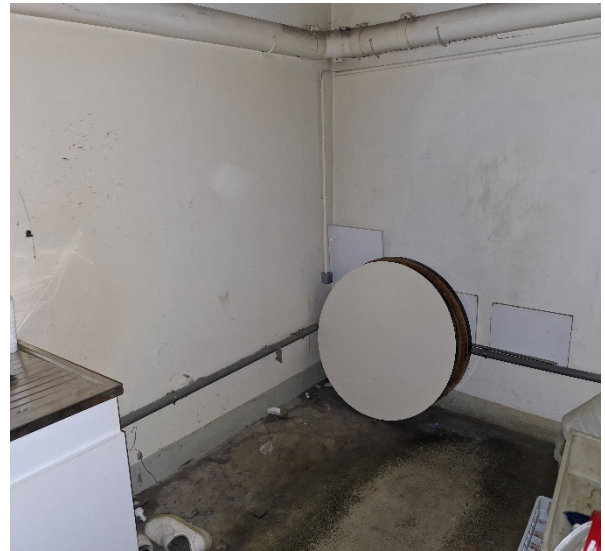
Pièce annexe n°2 avec arrivée d'eau
