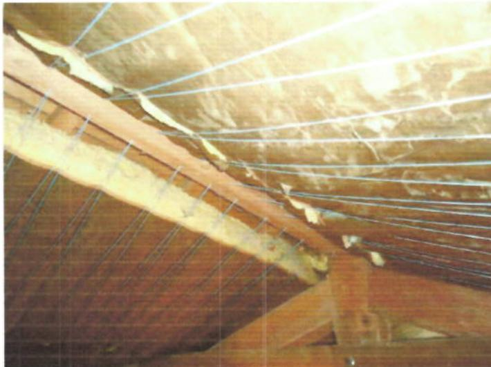
*Vue partielle sur charpente laquelle est isolée sous pentes*
