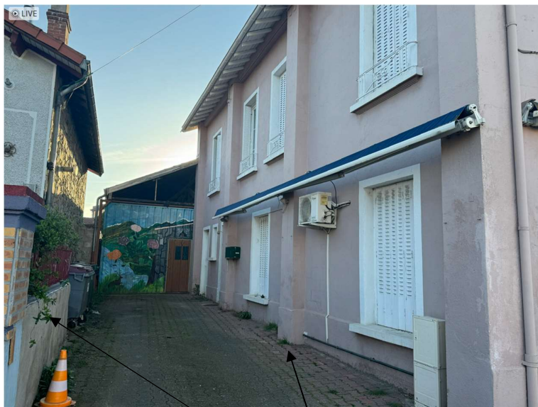
Mur voisin / Courette
