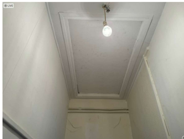
Trappe accès combles
