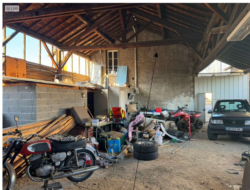
Aperçu de la façade exposée Sud-Ouest côté dépendance décrite Infra
