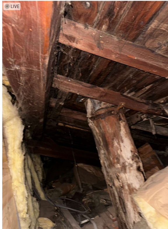
Aperçu charpente à surveiller
