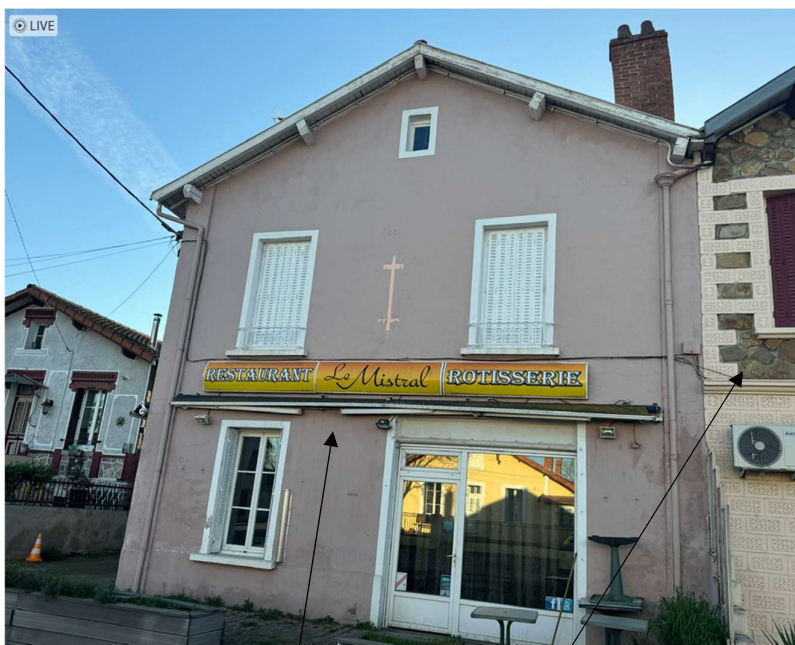
Façade orientée Nord-Est côté avenue d'Auvergne / Immeuble voisin mitoyen
