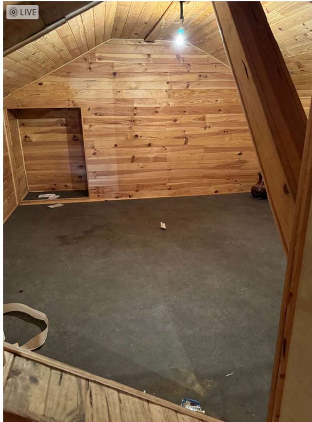
Pièce centrale combles
