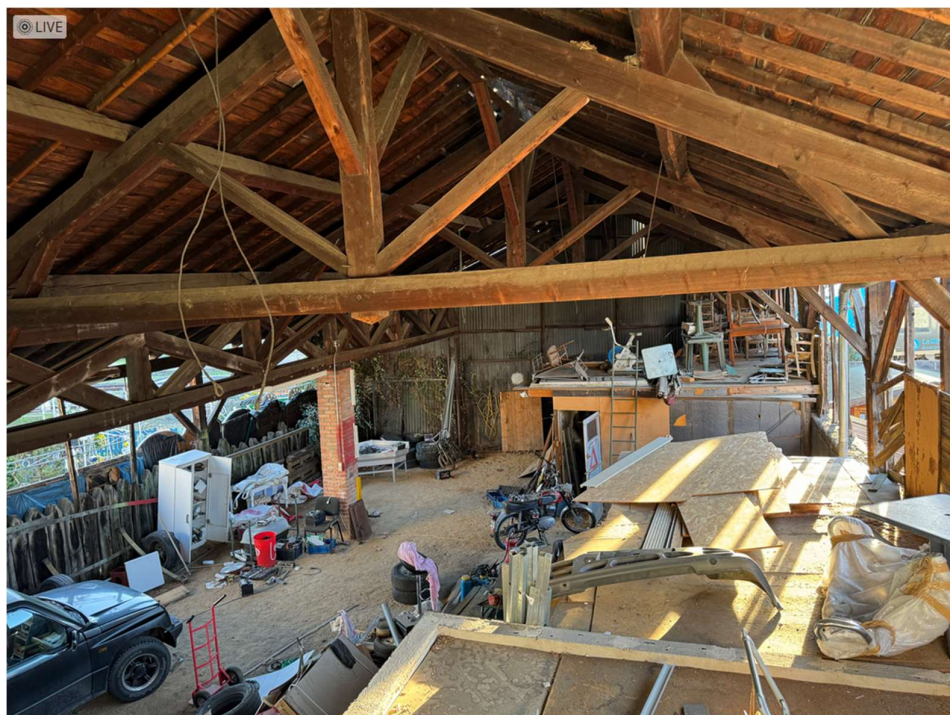
Vue générale du hangar (Terre battue au sol) / Photo prise d'une des chambres au 1 er étage
