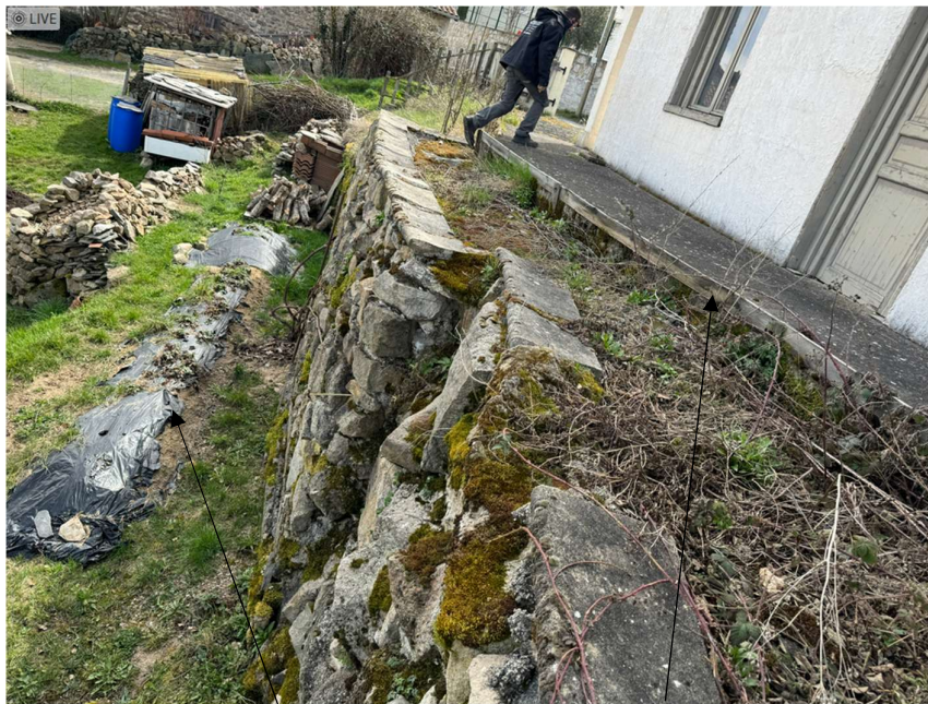
Propriété voisine en contrebas / Allée
