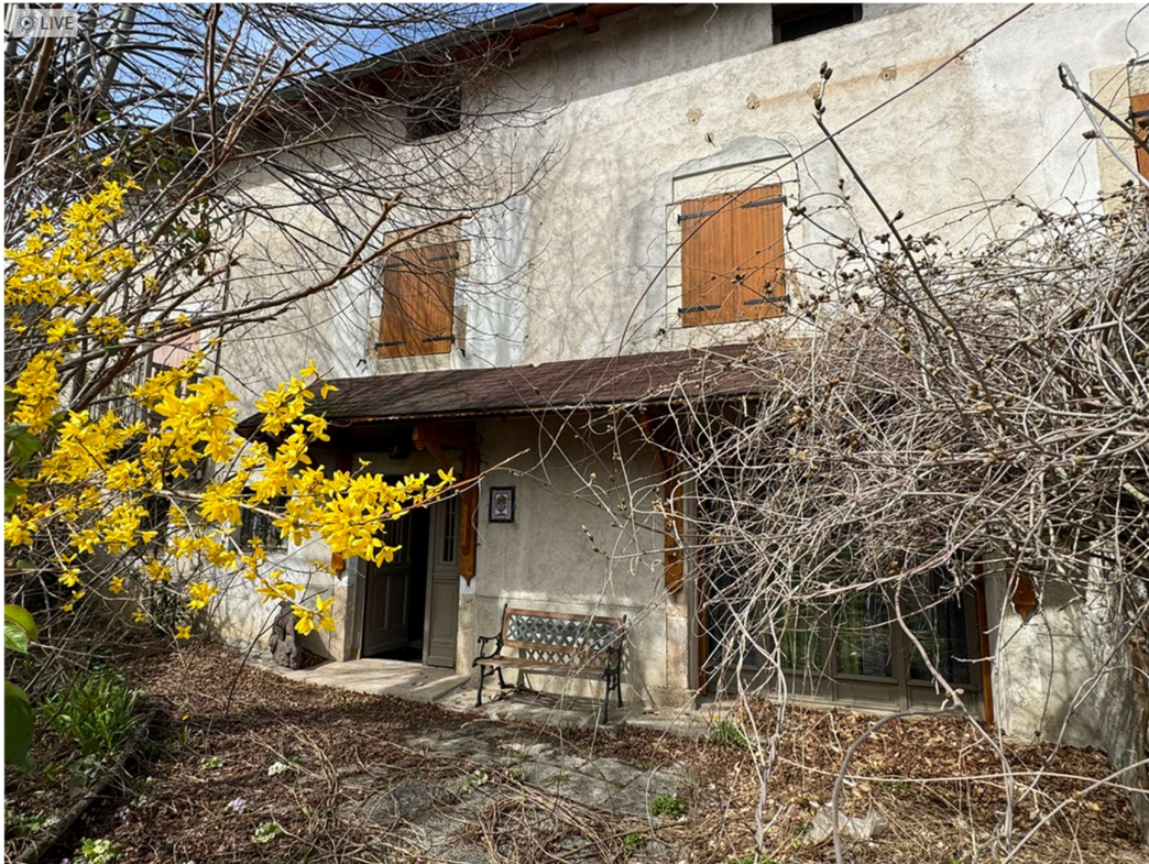
Façade orientée Sud-Est
