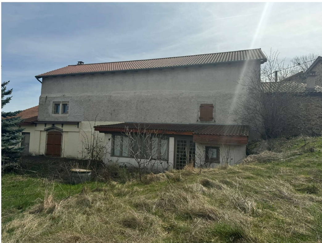
Façade exposée Nord-Ouest
