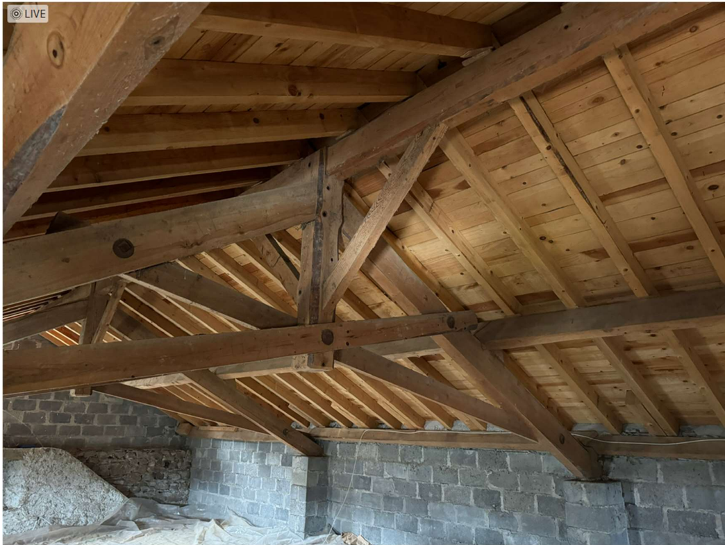
Charpente apparue en bon état d'entretien et de conservation
