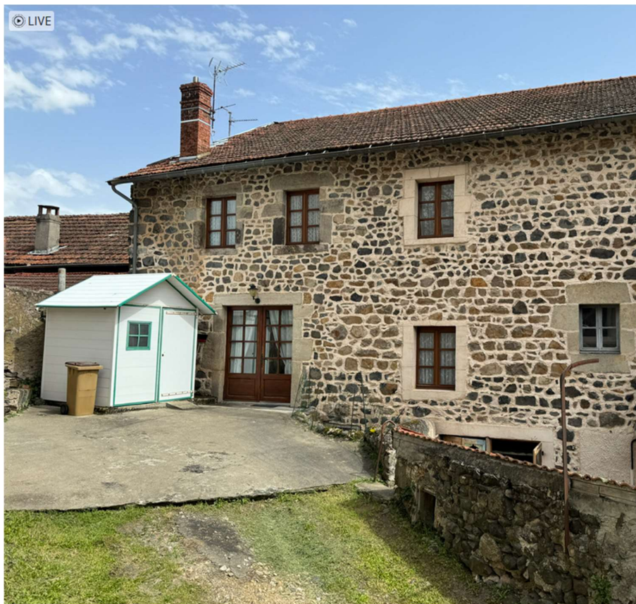
Façade côté rue du Moulin
