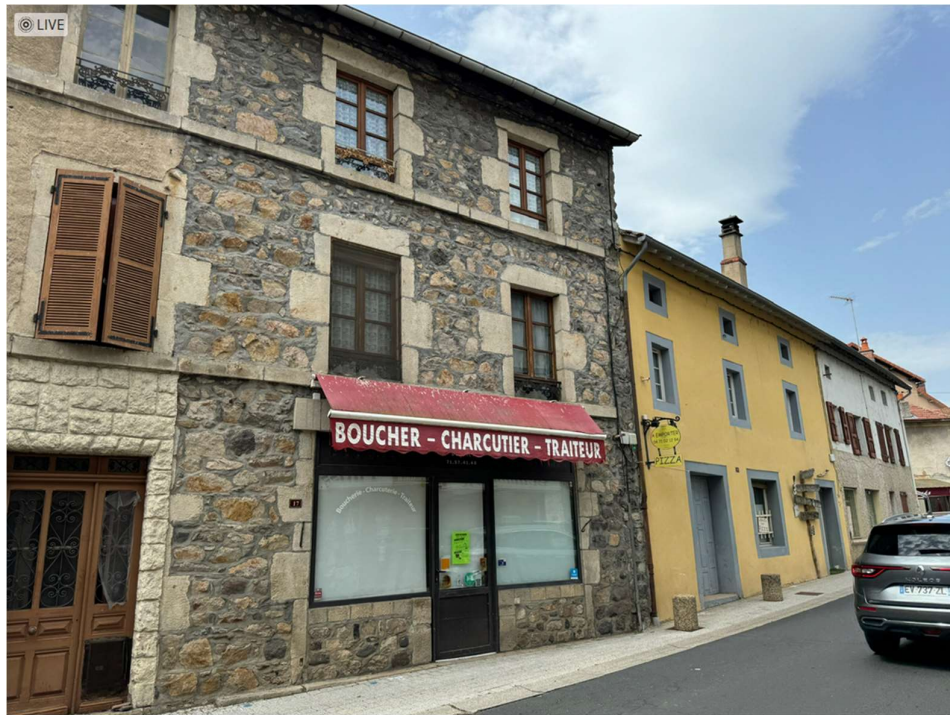
Façade prenant le jour côté n° 17 Grand-Rue
