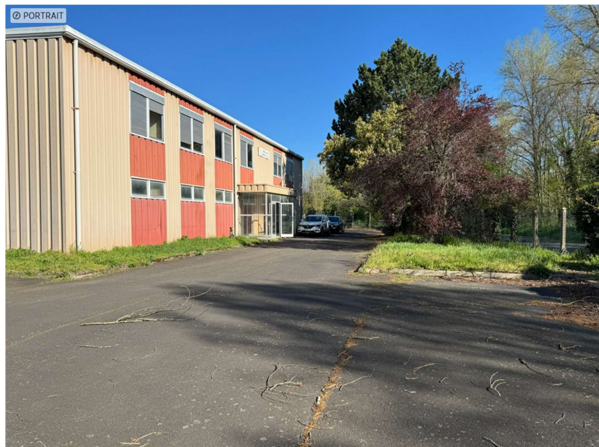
Terrain aspect Est bâtiment A
