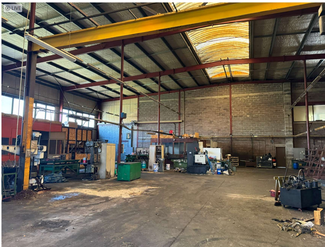
Autre point de vue de la partie ateliers
