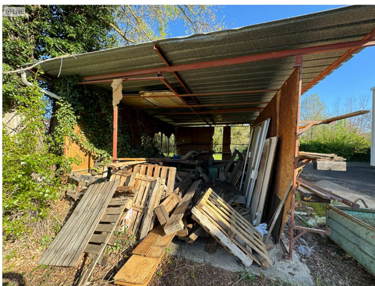
Construction sommaire utilisée en tant que débarras
