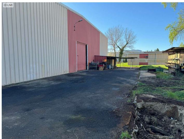
Abords goudronnés à l'Ouest du bâtiment A
