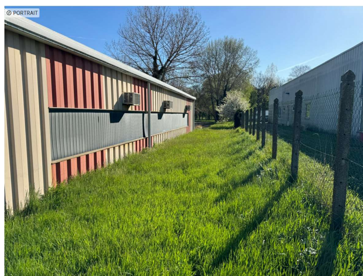
Bande de terrain aspect Est du bâtiment B
