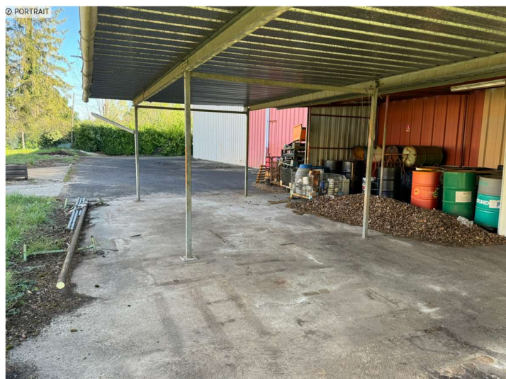
Auvent présent sur l'aspect Ouest
