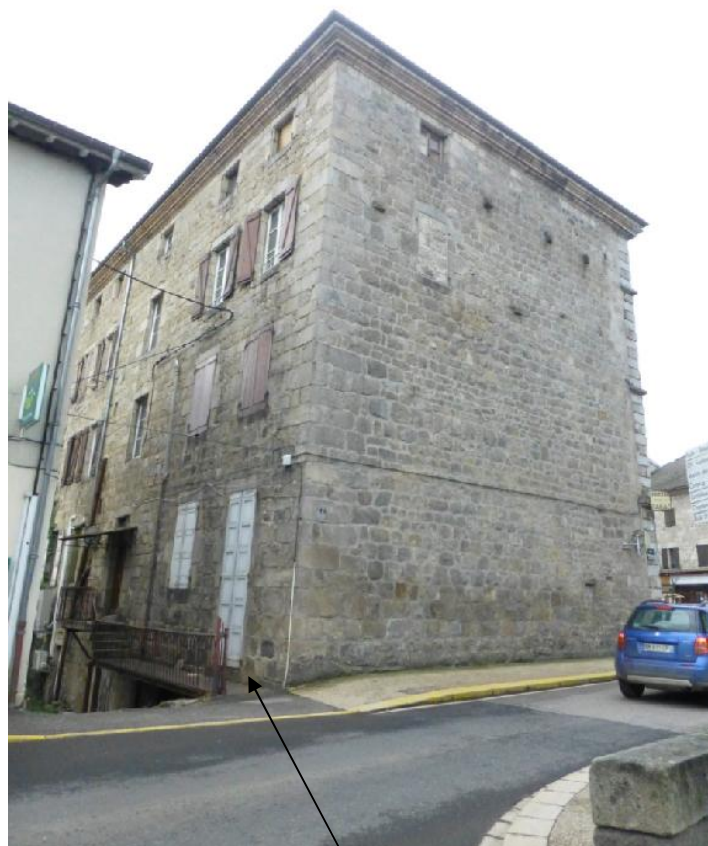
Accès piétonnier à l'entrée de l'immeuble (Rue d'Annonay)
