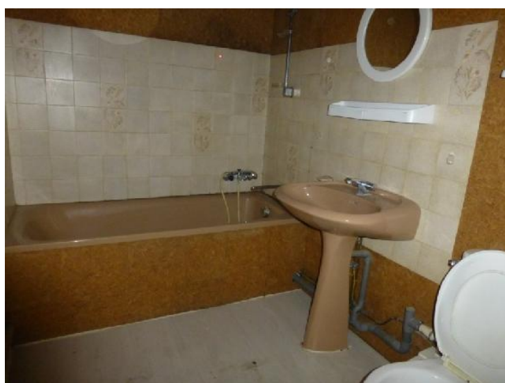
Salle de bains (lino au sol)
