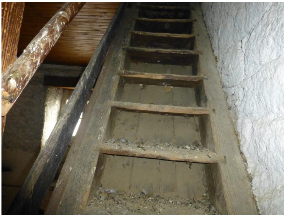
Echelle de meunier desservant les greniers (quatrième étage)
