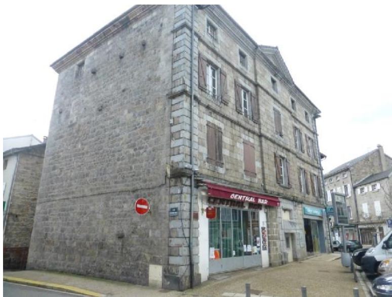
Façade exposée Nord / Façade exposée Ouest
