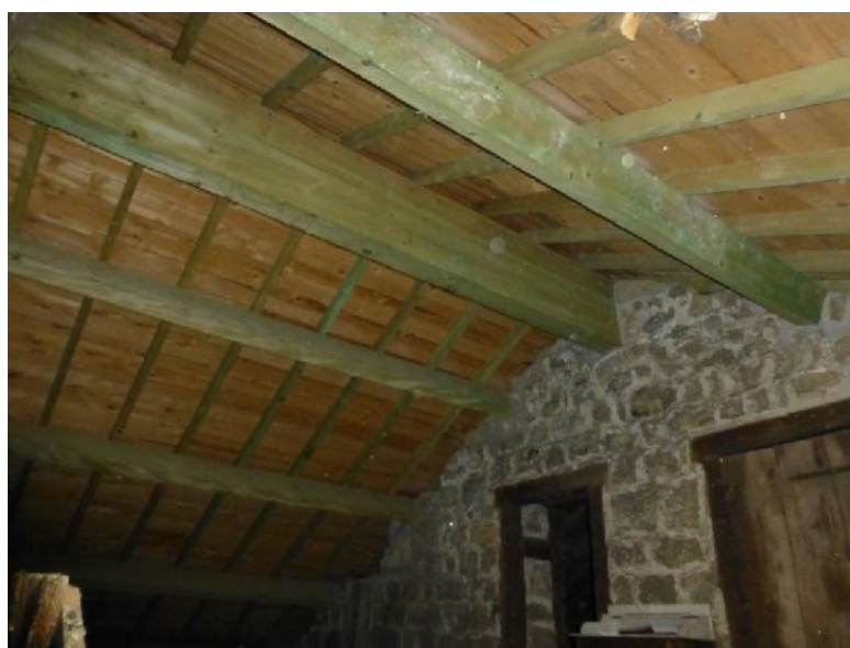
Vue sur partie de la charpente
