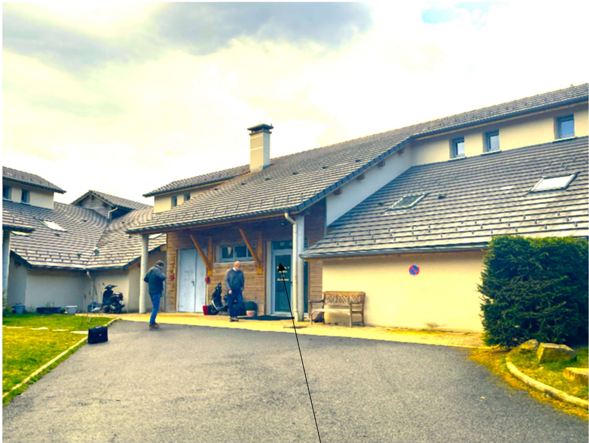
Bâtiment 1 / Entrée (Aspect Nord)
